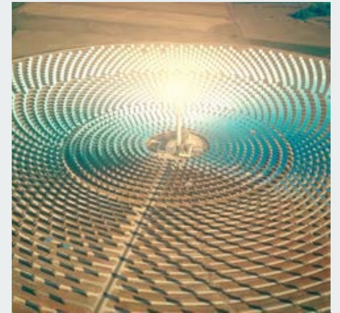
CENTRALE SOLAIRE À CONCENTRATION DE 150 MW
