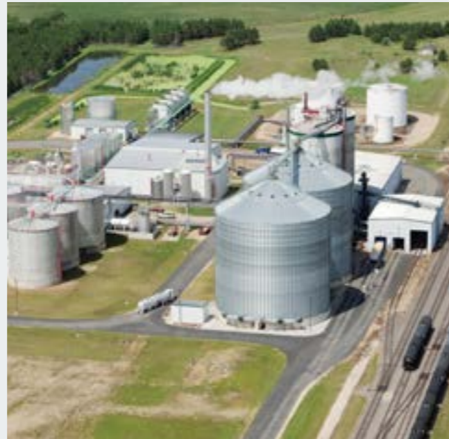
CENTRALE D'ÉNERGIE RENOUVELABLE
