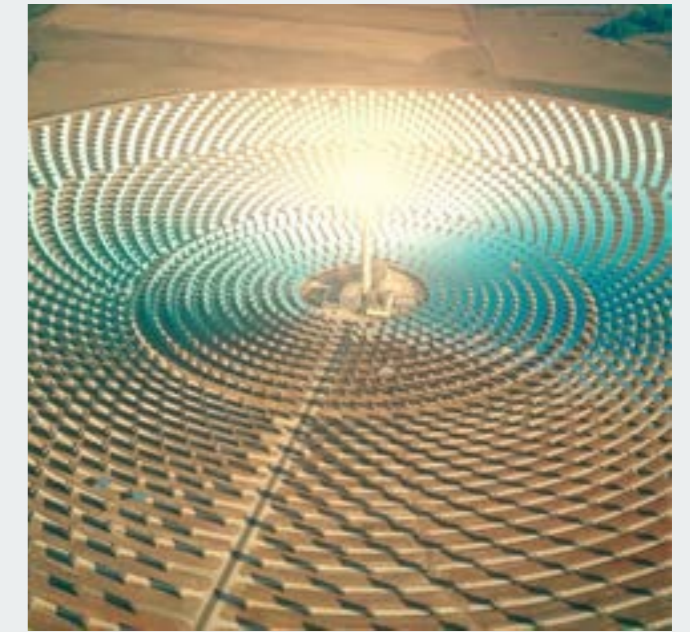
150MW 集光型太陽光発電所
