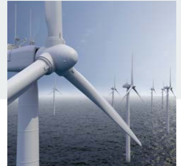
洋上風力発電所
