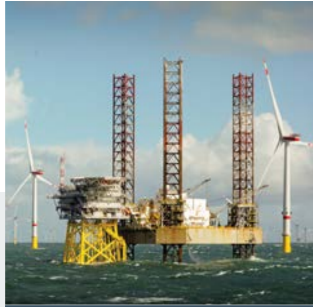
712MW 洋上風力発電所
