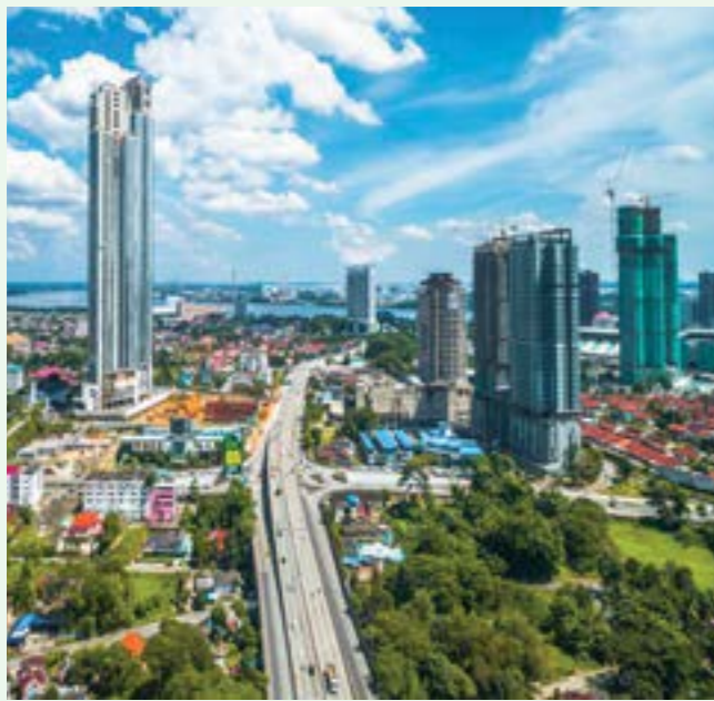
37階建てオフィスタワー
