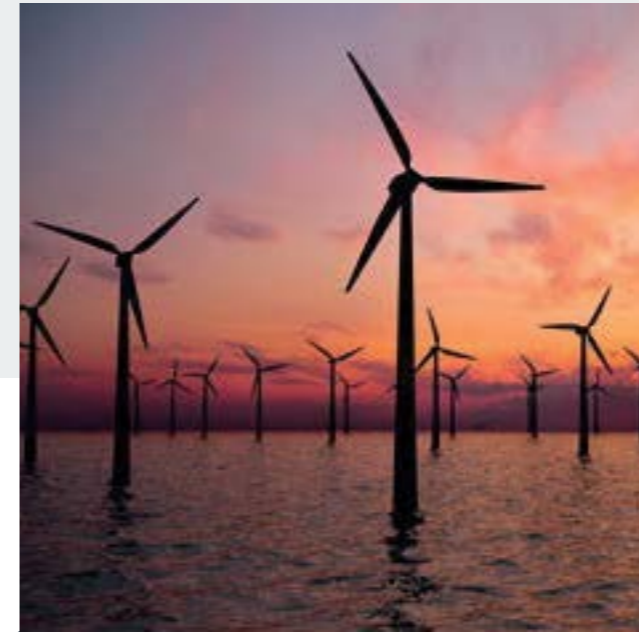
洋上風力発電所
