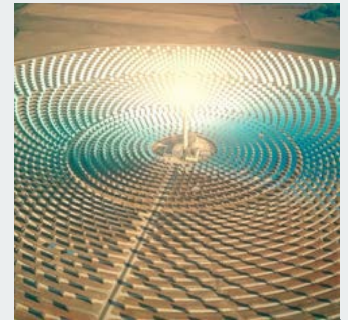
NHÀ MÁY ĐIỆN MẶT TRỜI TẬP TRUNG 150 MW
