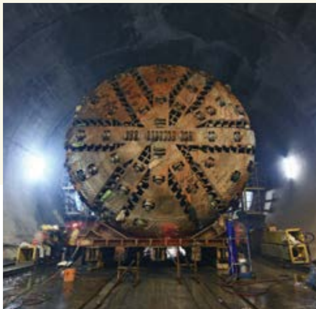
مشروع حفر أنفاق مياه الصرف الصحي
