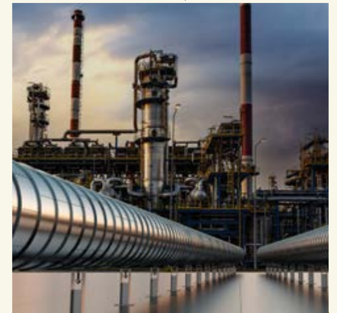
مرفق المعالجة المركزية لحقول الغاز وخطوط الأنابيب
