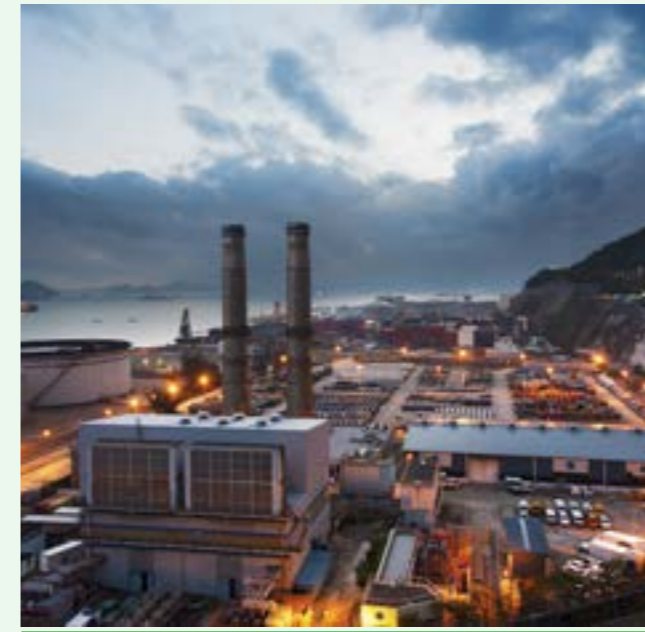
محطة توليد الكهرباء بالديزل
